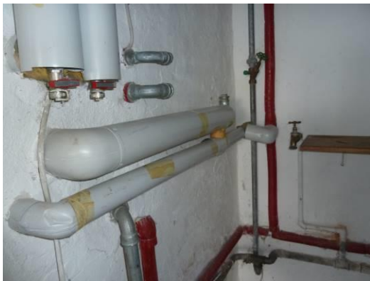
Leitungen aus den Nachbargebäude
