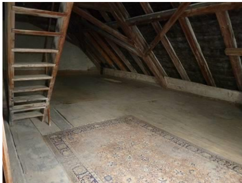
Erste Ebene Dachstuhl
