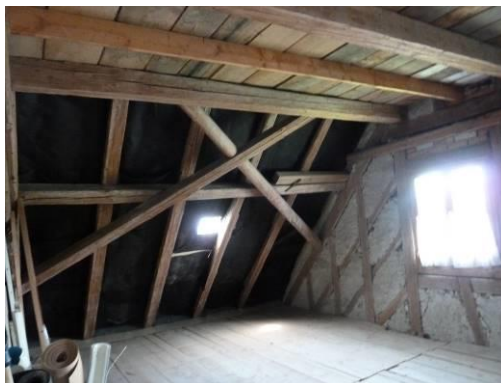
Erste Ebene Dachstuhl
