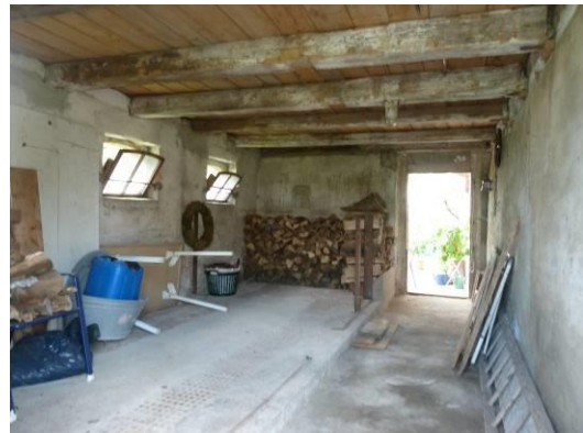
Innenbereich Anbau Schweinestall
